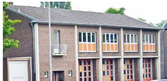
Die ehemalige Hülser Feuerwache wird abgerissen und dafür ein Wohn- und Geschäftshaus gebaut.
