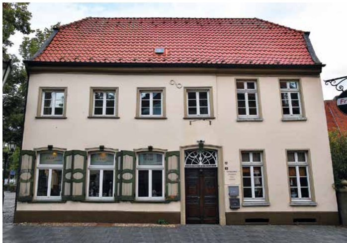
Der erste Auftrag nach der Firmengründung war die Dacheindeckung eines Hauses im Hülser Ortskern.
