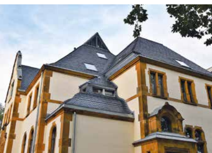
Das denkmalgeschützte Haus beeindruckt mit einem schönen Schieferdach.
