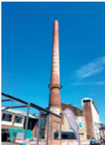
Seit Ende Juni wurde der markante Schornstein der früheren Firma Kress, heute MAYS//WERK, umfangreich saniert. Der aus dem Jahre 1924 stammende gemauerte riesige Schornstein wurde im Zuge der Sanierungsarbeiten auch in der Höhe drastisch reduziert: von 54,50 Metern auf 19,90 Meter. Zwei Wochen dauerten die Arbeiten, dann ging der Schornstein in neuem Look wieder in Betrieb.
